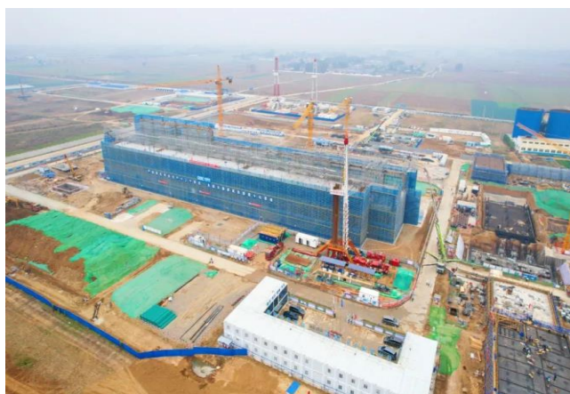
图 38：山东泰安压缩空气储能创新示范项目建设现场
