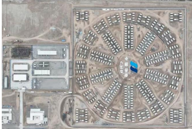
图 25：华电喀什百万储能项目
