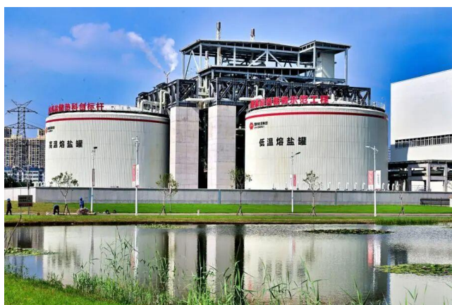
图 18: 国家能源集团安徽公司宿州电厂熔盐储能项目
