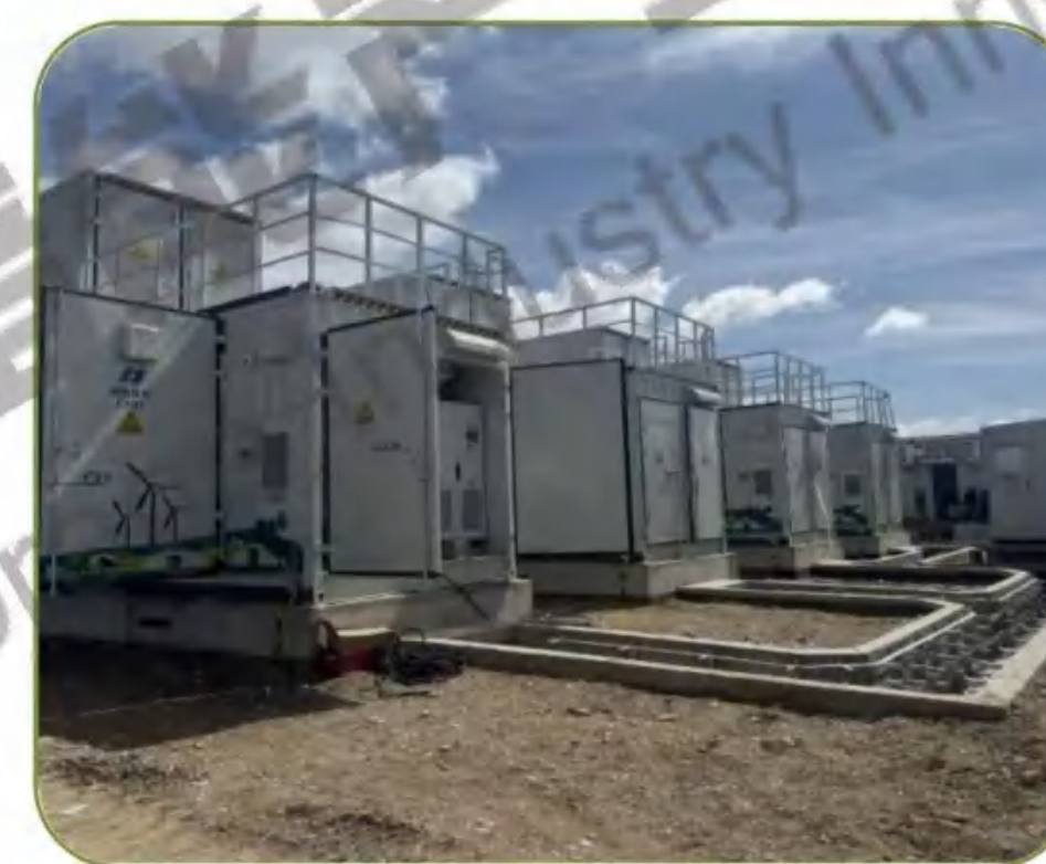
MW 级锌溴液流电池储能系统
