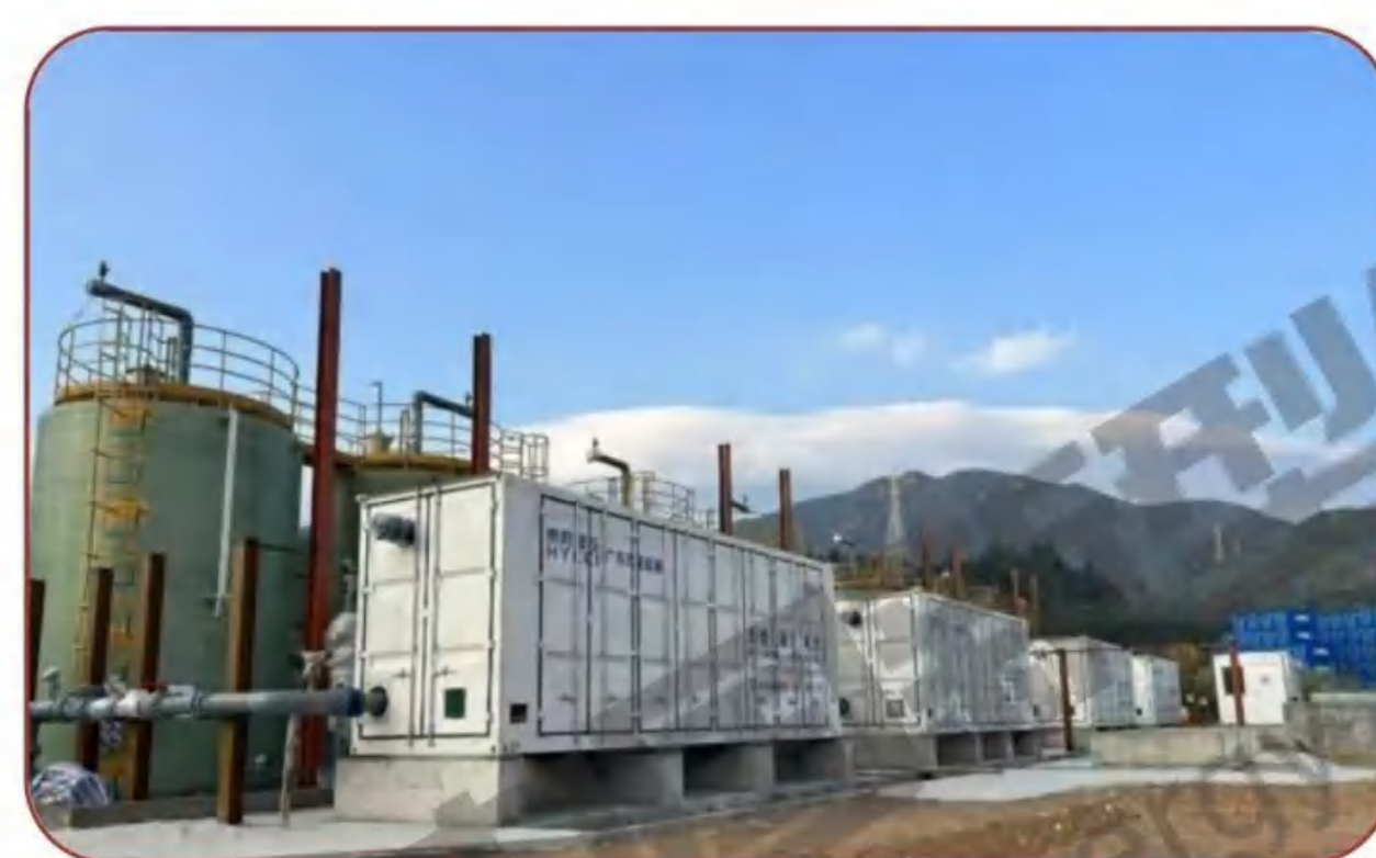
500kW 铁铬液流电池储能模块
