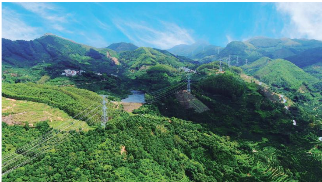
图 1-2 闽粤电力联网工程
