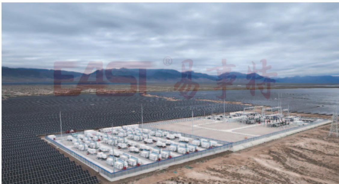
图 20 青海海西克鲁克 75MW/300MWh 共享储能项目
