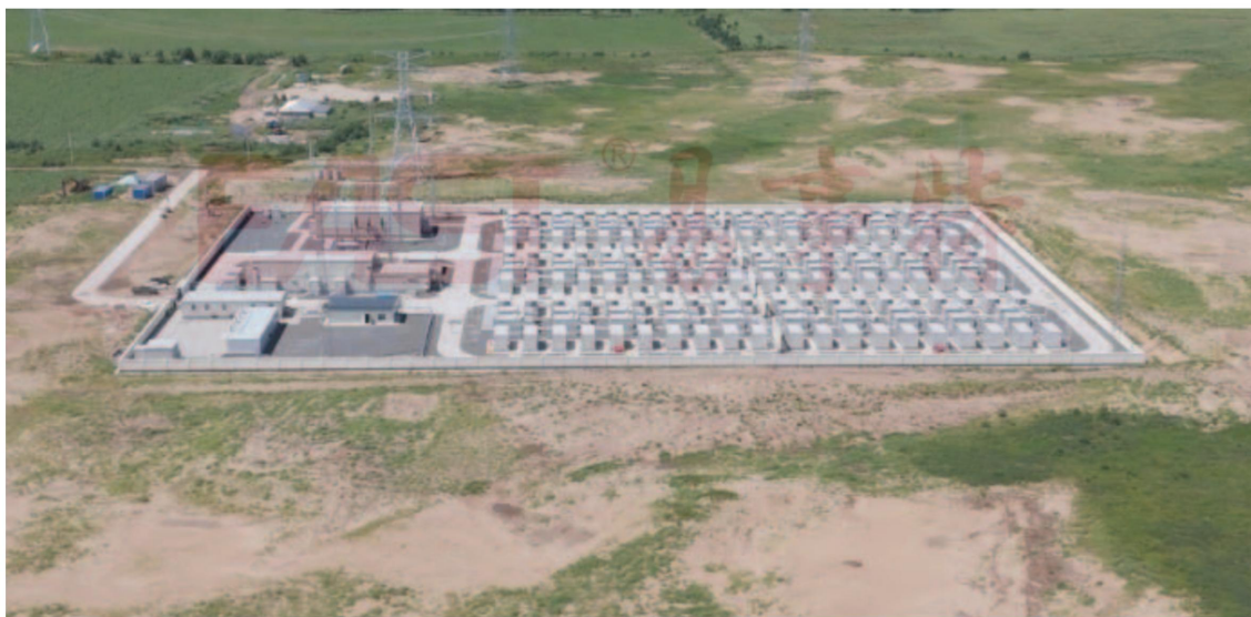
图 18 大唐赤峰康家营电网侧 150MW/600MWh 独立储能项目
