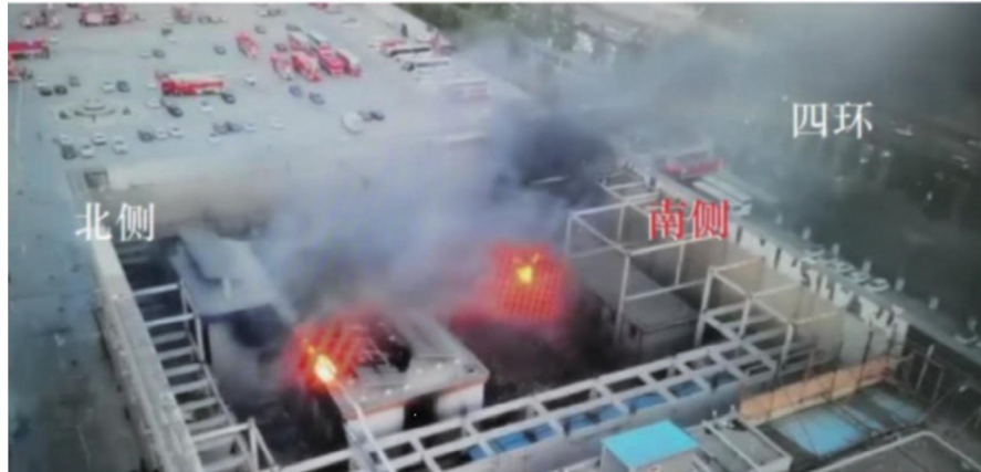
图5 北京大红门安全事故照片 来源：电科院北京集美大红门25MWh 直流光储充一体化电站项目事故分析报告
