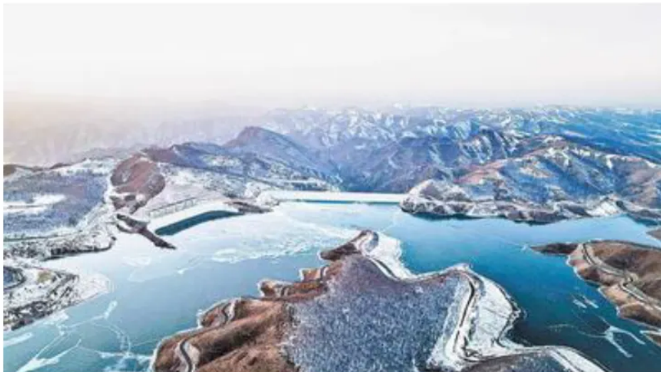
河北丰宁3600兆瓦抽水蓄能电站
