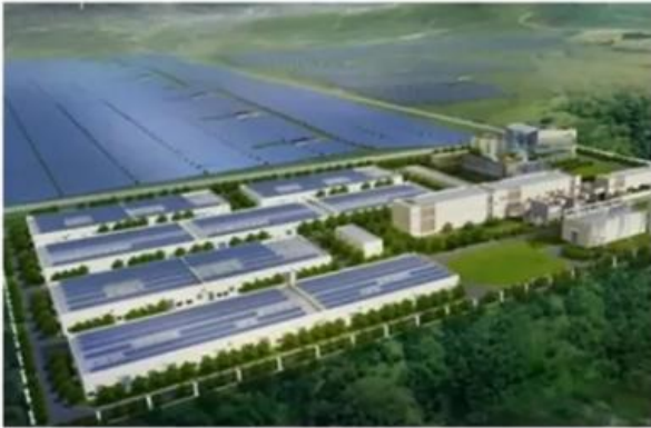
国家风光储输 示范工程建成
