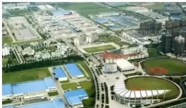
江苏无锡新区星洲工业园 全国最大容量商业储能 电站运行
