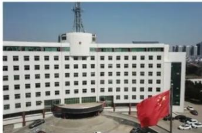
全国首个政务楼宇光伏 储能项目落地安徽
