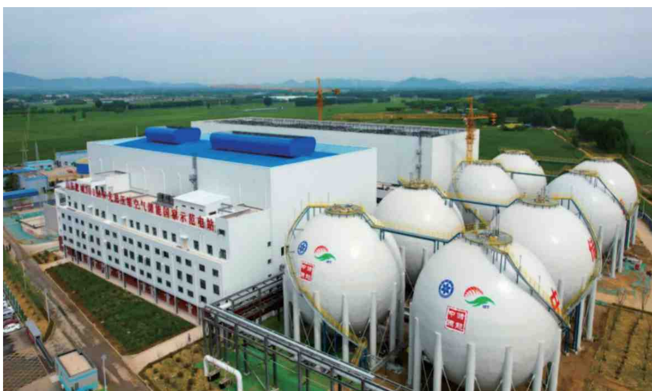
图 3.6-4 山东肥城 300MW 压缩空气储能示范项目
