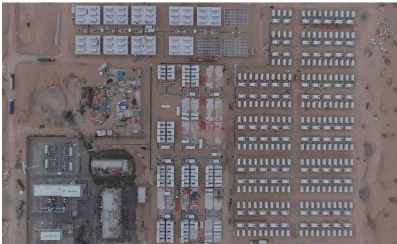
图 3.6-3 内蒙古磴口储能项目
