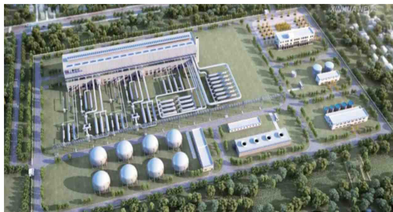
图 3.3-3 湖北应城 300MW 压缩空气储能项目
