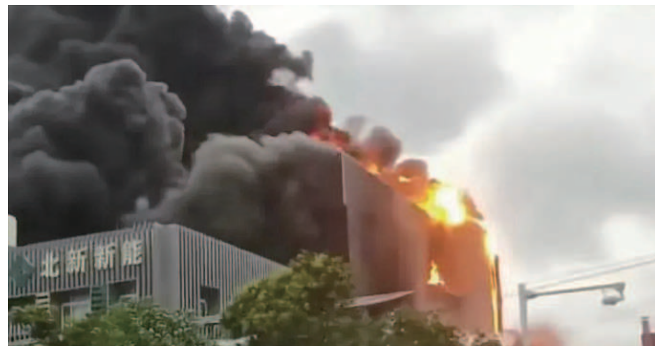
图 8-4 南通北新新能源发生火灾事故
