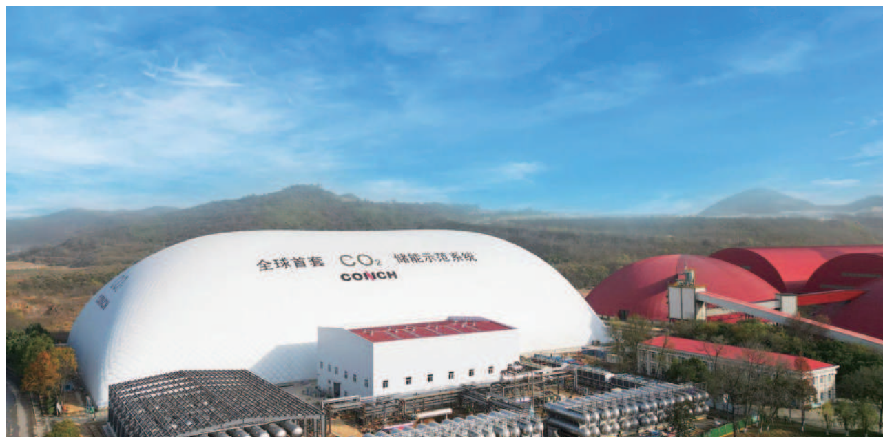
图 9-2 芜湖海螺 10MW/80MWh 新型二氧化碳储能商业示范项目
