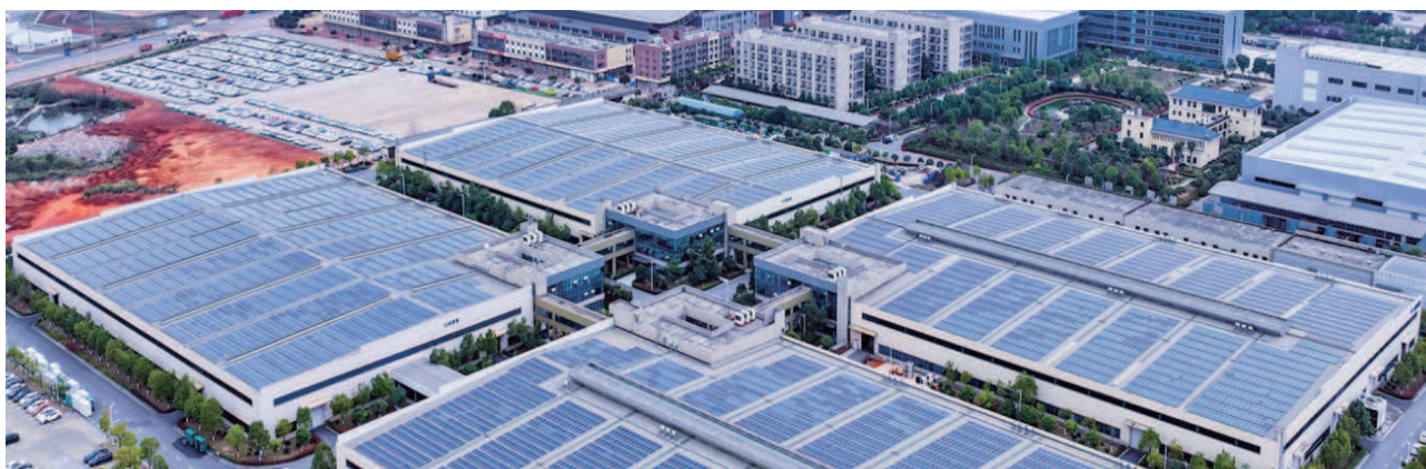
图 9-9 汨罗循环经济产业园区智慧绿色微电网
