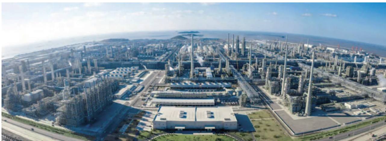
图 9-4 浙石化储能电站项目
