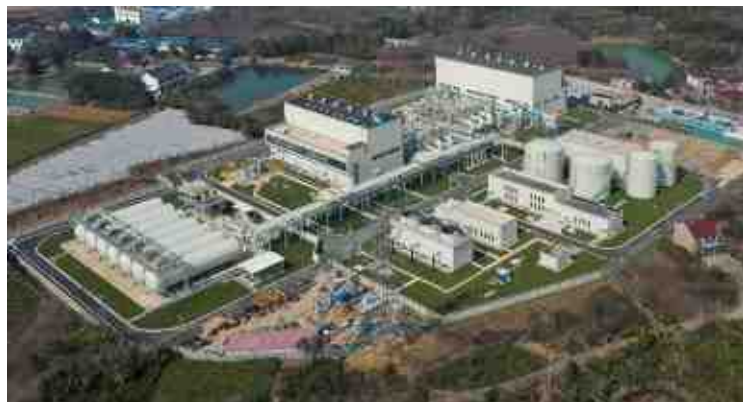
江苏金坛盐穴压缩空气储能国家示范项目全景
