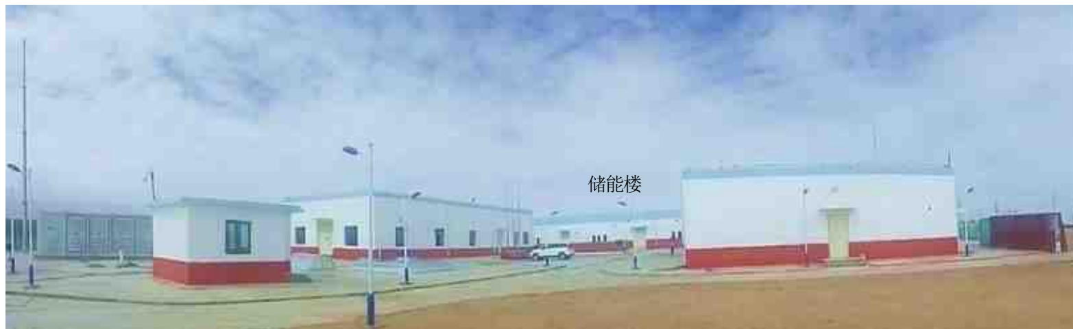
青海格尔木光储项目
