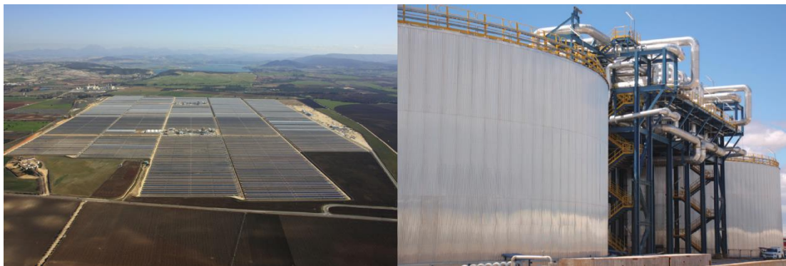
图 5-52：混合太阳能发电项目整体鸟瞰图和项目使用的双罐熔盐储热系统
