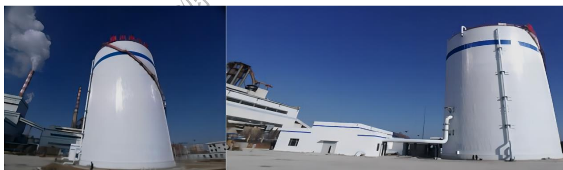
图 5-56：项目水储热罐实景图
