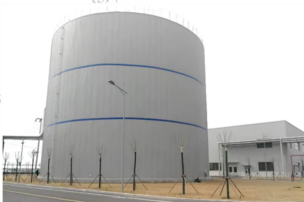
图 5-35：项目水蓄冷罐实景图
