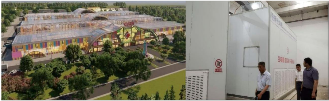
图 5-49：红山花卉市场谷电固体蓄热供暖机组实景图
