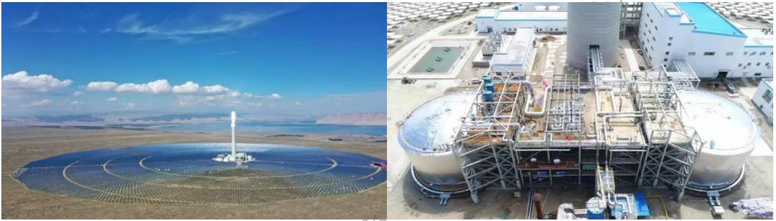
图 5-54：中电建青海共和塔式熔盐储热光热项目整体鸟瞰图和项目双罐熔盐储热系统实景图
