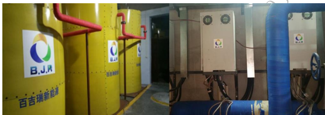
图 5-33：项目熔盐蓄热单罐供暖系统
