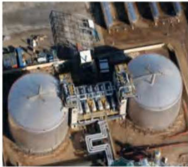
调峰火电厂（电加热+熔盐储热）
