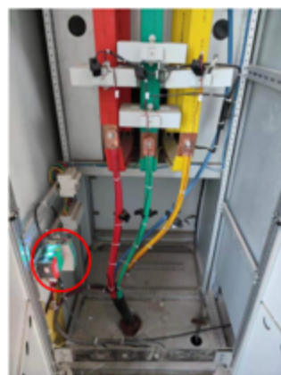
现场隐式安装的IPT雾网络分布式智能测控节点(圆圈中香烟盒大小的彩壳)
