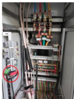
现场隐式安装的IPT雾网络分布式智能测控节点(圆圈中香烟盒大小的彩壳)
