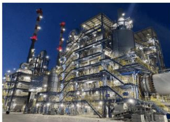
图15: 山东裕龙产业园危废焚烧项目
