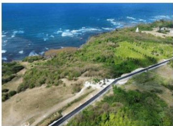
图12： 巴巴多斯苏格兰地区道路修复项目
